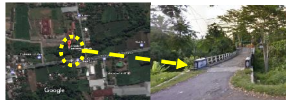
Gambar 1. Lokasi Jembatan Puskesmas Narmada
